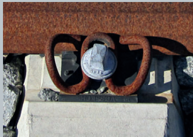
Kleinteil zur Befestigung von Schienen (Stahl)
